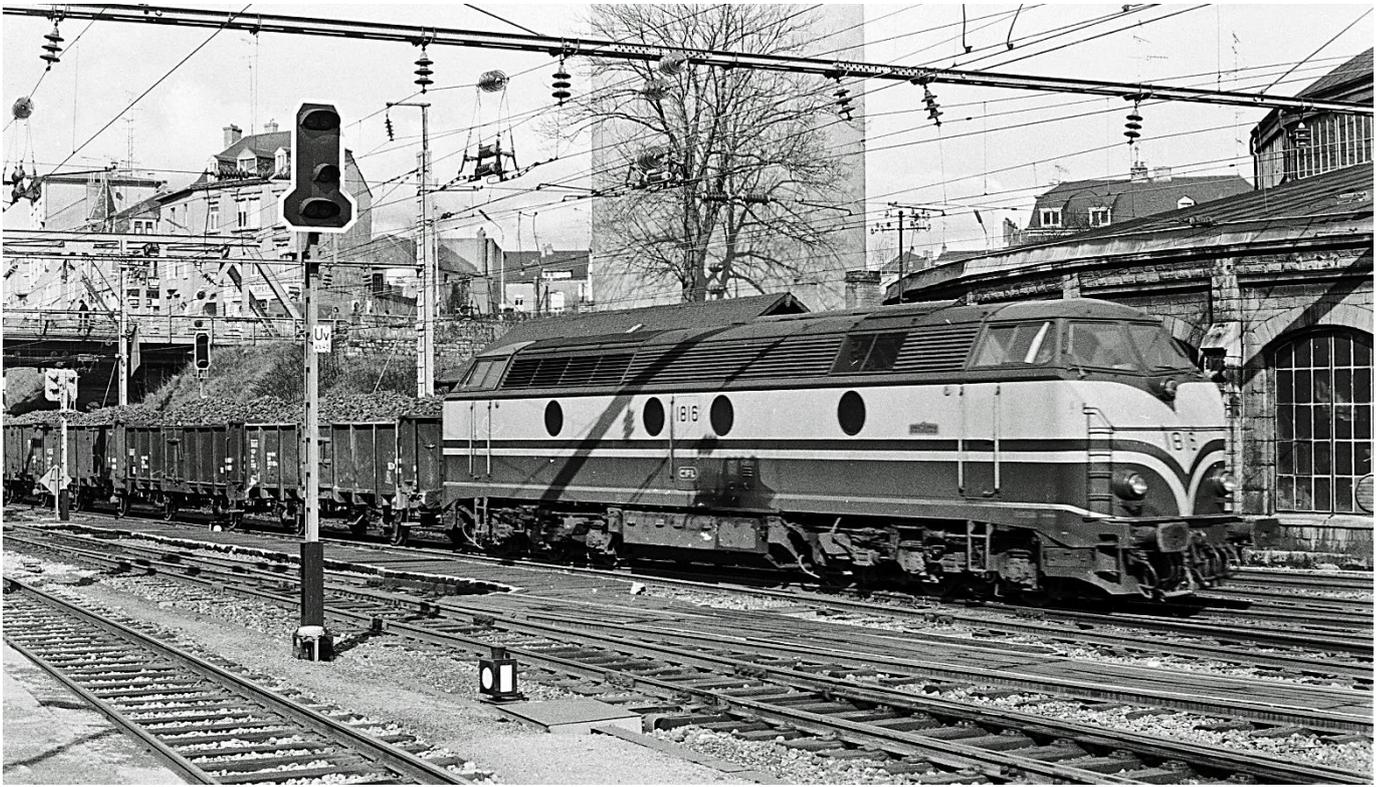
Eine Lok der CFL-Reihe 1800, eine Konstruktion von BN - La Brugeoise-Nivelles, ebenfalls dieselektrisch, Achsfolge Co'Co', bei Einfahrt in Luxembourg mit Güterzug. 📷 1975
